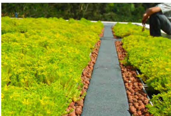
Figura 4: Qualquer casa ou edifício pode comportar um telhado verde, desde que realizado corretamente, com a devida impermeabilização. Fonte: EcoCasa. Disponível em < http://www.ecocasa.com.br/acpu_img/telhado-verde.jpg >, acesso em 25/05/2013.
