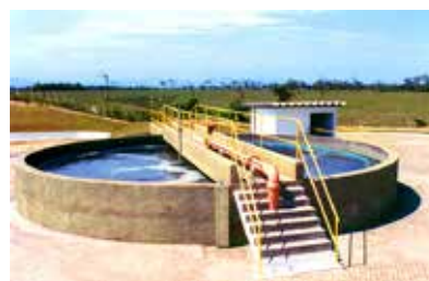
Imagem 2. Tanque de decantação. Fonte: http://www.echowater.com.br/imagens/1069756_orig.jpg (Acesso em 01/04/2015).
